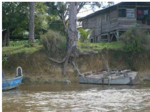
Affaissement de berge sur le fleuve Maroni @DEAL Guyane)
