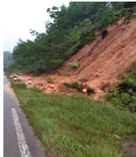
Éboulement sur la RN1 - Guyane @DGTM Guyane
