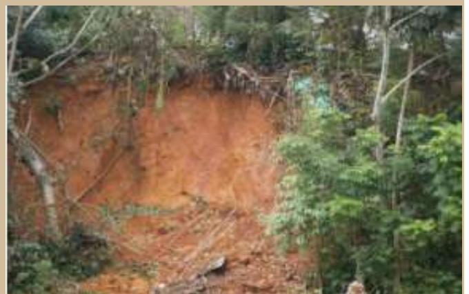
Mont Baduel Glissement de terrain (@DEAL Guyane)
