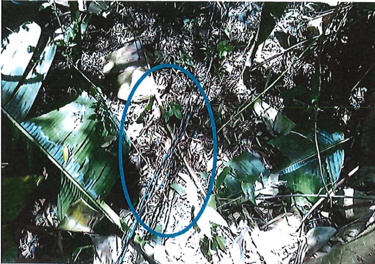
Cliché du câbles traversant le bosquet et rejoignant les habitations spontanées.
