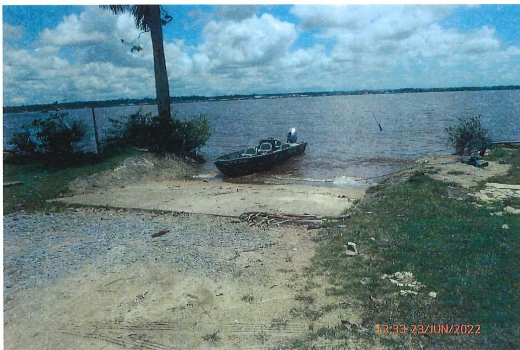
L'ensemble de la zone gravillonnée et stabilisée de la berge d'accès à l'eau est de 65 m longueur et 16 m de large
